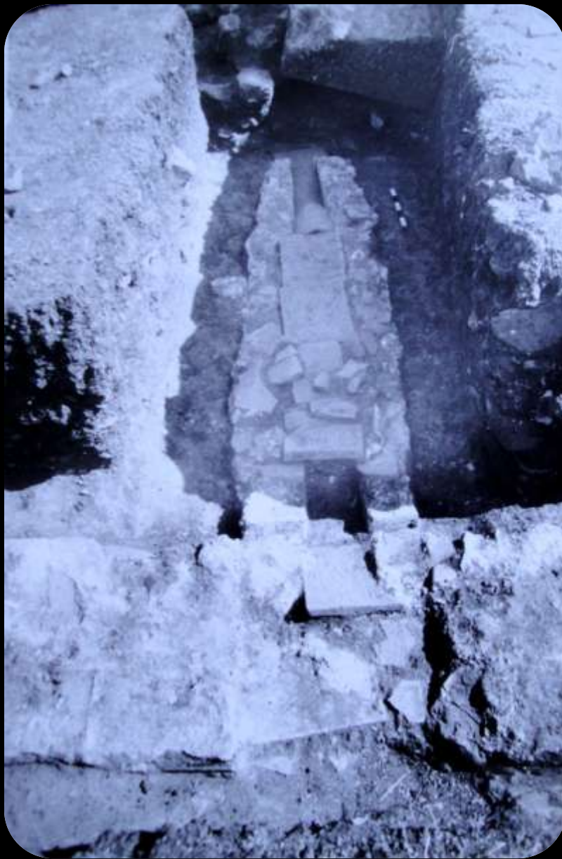
Ο χτιστός αποχετευτικός αγωγός
